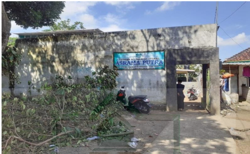
Gambar 1.3 Tampak Depan Asrama Putra Pondok Pesanteren Al- Islahul Ittihad Jabon Tenten
