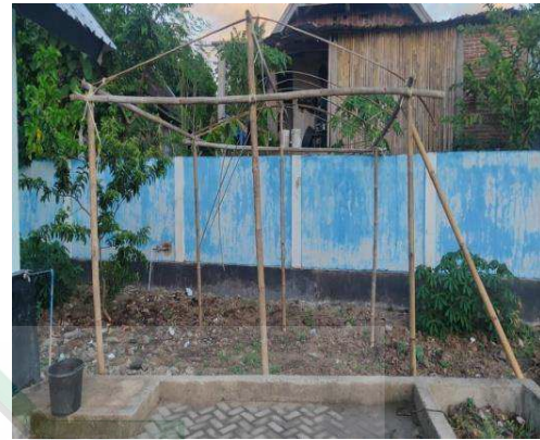
Proses pembangunan kantin sekolah dilokal baru TK Negeri 3 Taliwang
